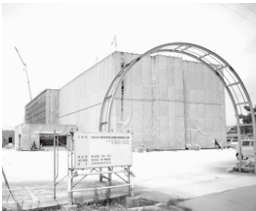
工事が進められている、中央公民館の外壁大規模改修
