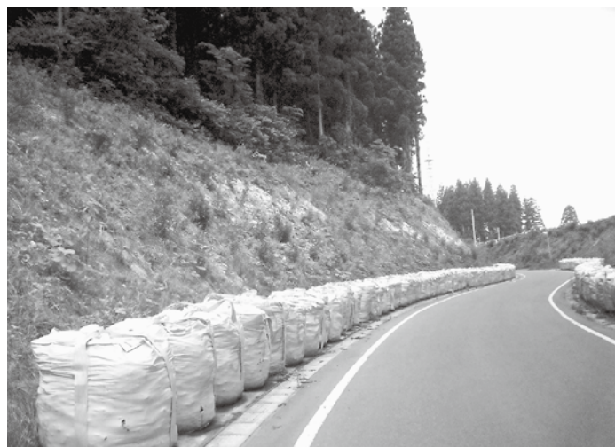
村道下牛潜長沢前線法面保護 工事前の応急措置
