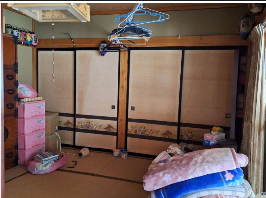
内部状況(2階和室)
